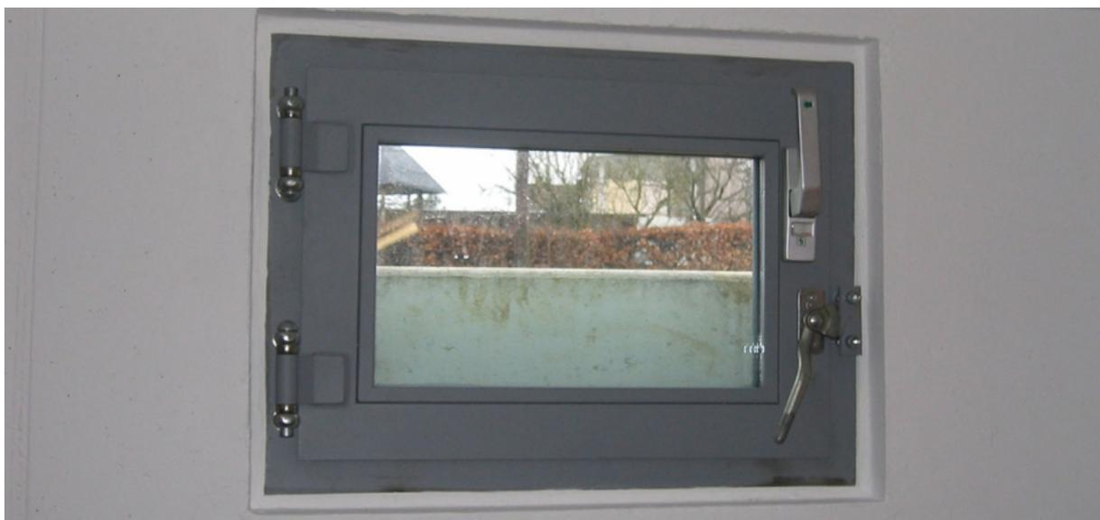
**Abbildung 15:** Hochwassersicheres Kellerfenster aus der HF50-Reihe [31].
